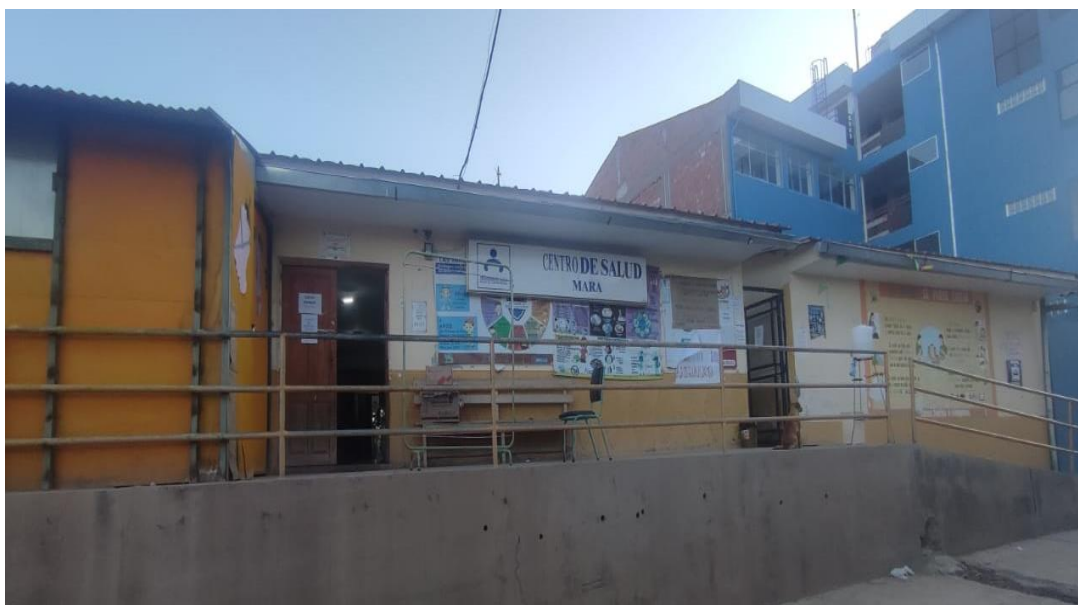
Foto 004. Centro de Salud del Distrito de Mara.
